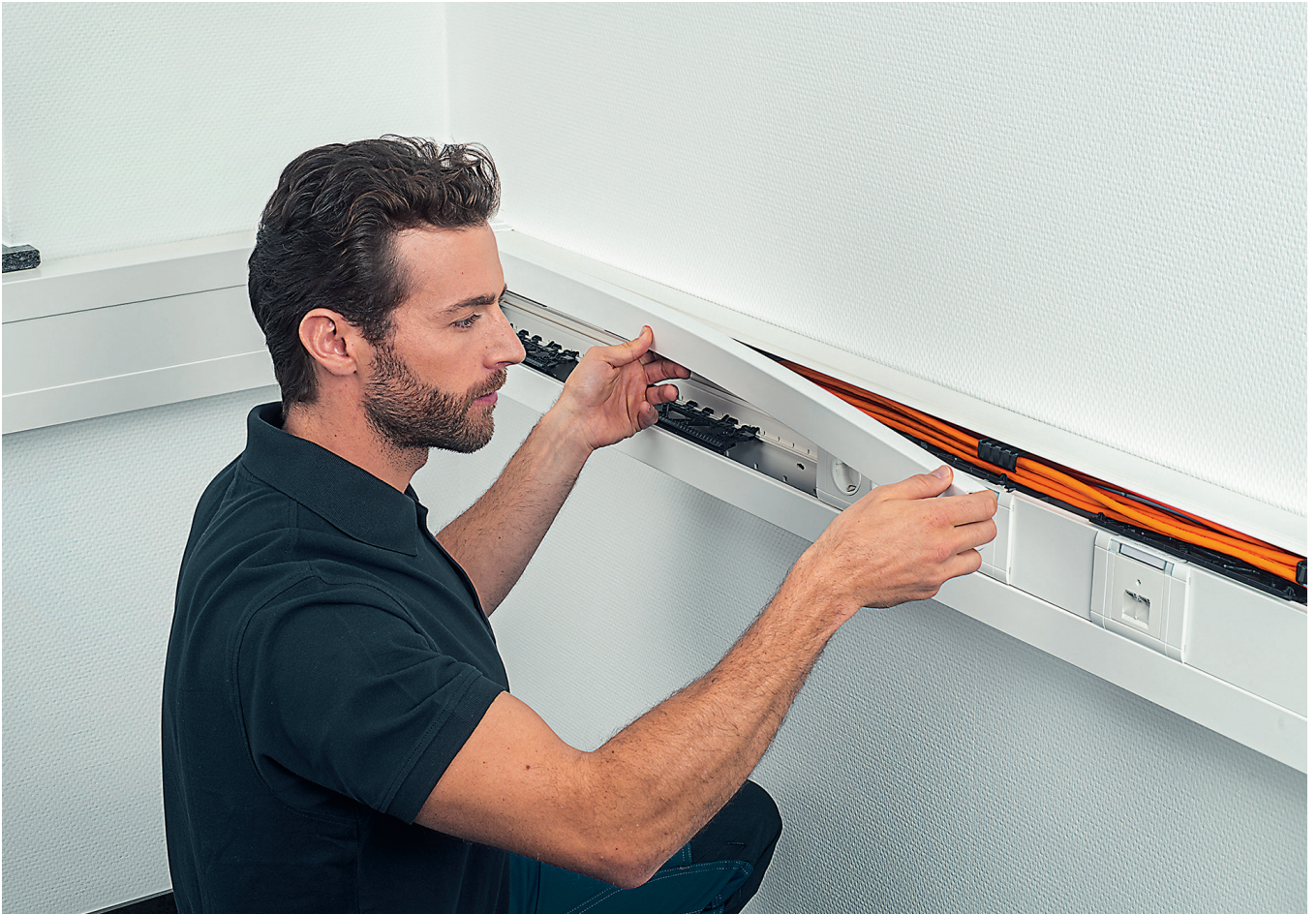
Bild 1: Die abnehmbaren Seitenoberteile lassen sich einfach aufbringen und auch verwindungsfrei wieder nach vorne abziehen
