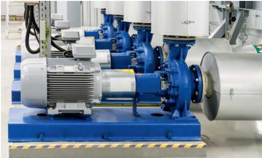
Bild 4: Die aktuell geltende Verordnung für Motoren spart bisher pro Jahr 57 TWh elektrische Energie ein
